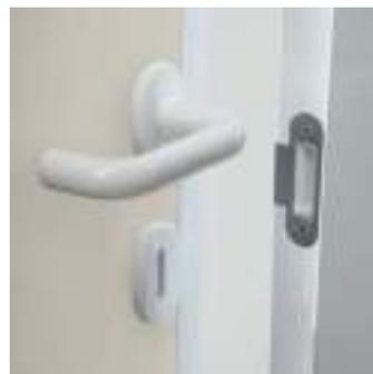
LA GUARNIZIONE DI BATTUTA DELLO STIPITE È GRIGIA O BIANCA E LA CONTROPIASTRA IN ACCIAIO È IMPOSTATA PERFETTAMENTE DENTRO IL PROFILO.
