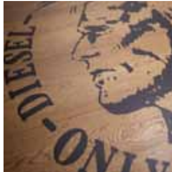
Realizzazione ad intarsio del marchio DIESEL su un pavimento prefinito BERTI.
